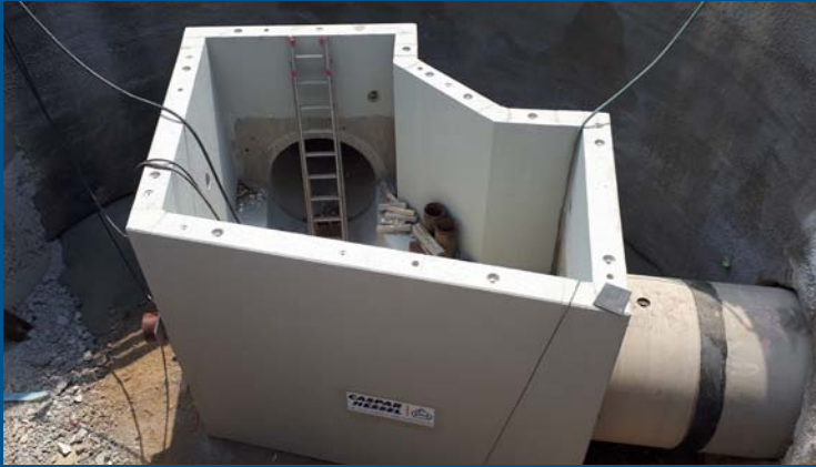
Blick in die Doppelstartbaugrube mit gesetztem Schachtunterteil
