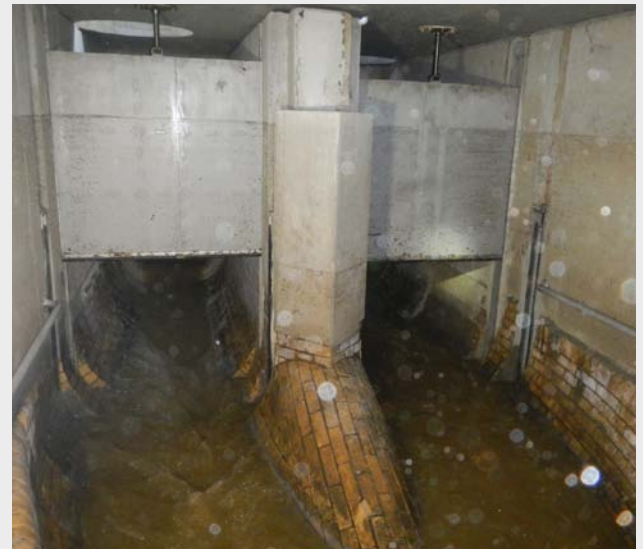
Teilerneuerung eines Dükerbauwerks mit neuen Absperschützen
