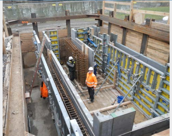
Teilerneuerung eines Dükerbauwerks
