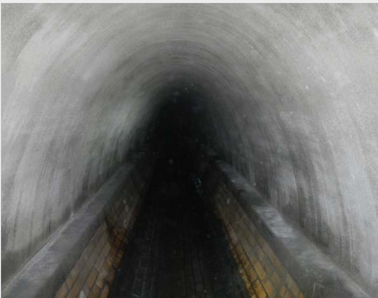
Sanierter Hauptsammelkanal
