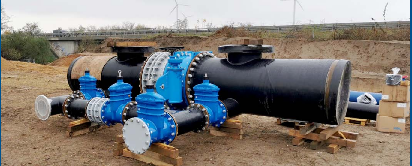
Erneuerung eines Knotenpunkts DN 1000 mit Armaturengruppe
