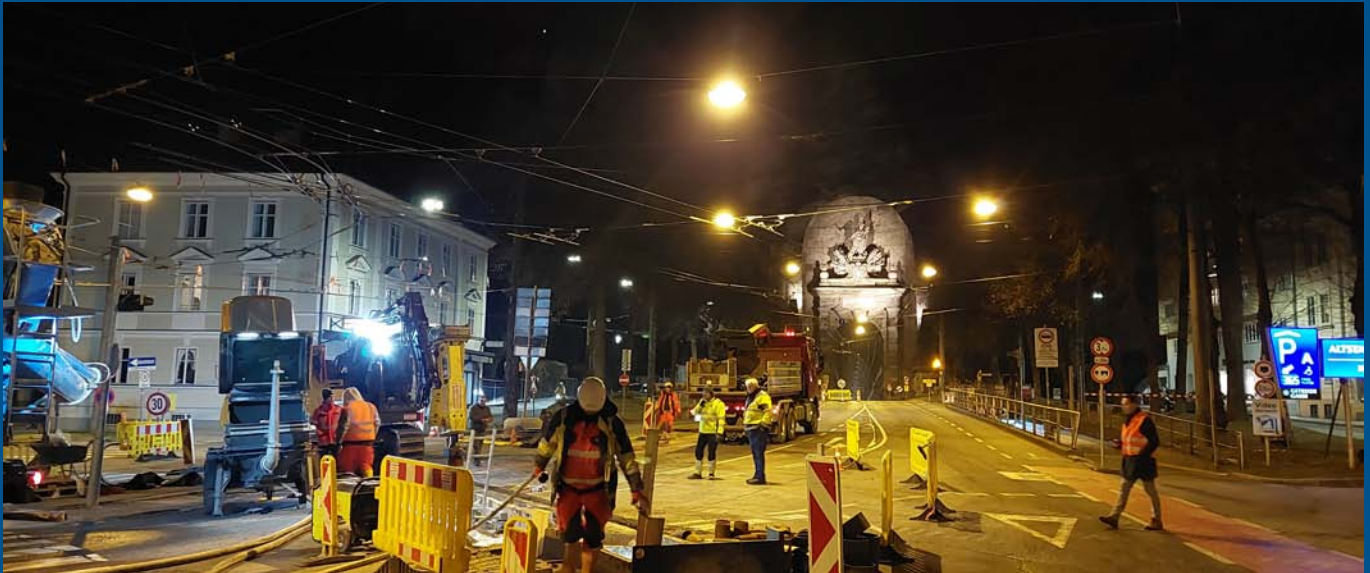
Nachteinsatz Pfähle mit Oberleitungen
