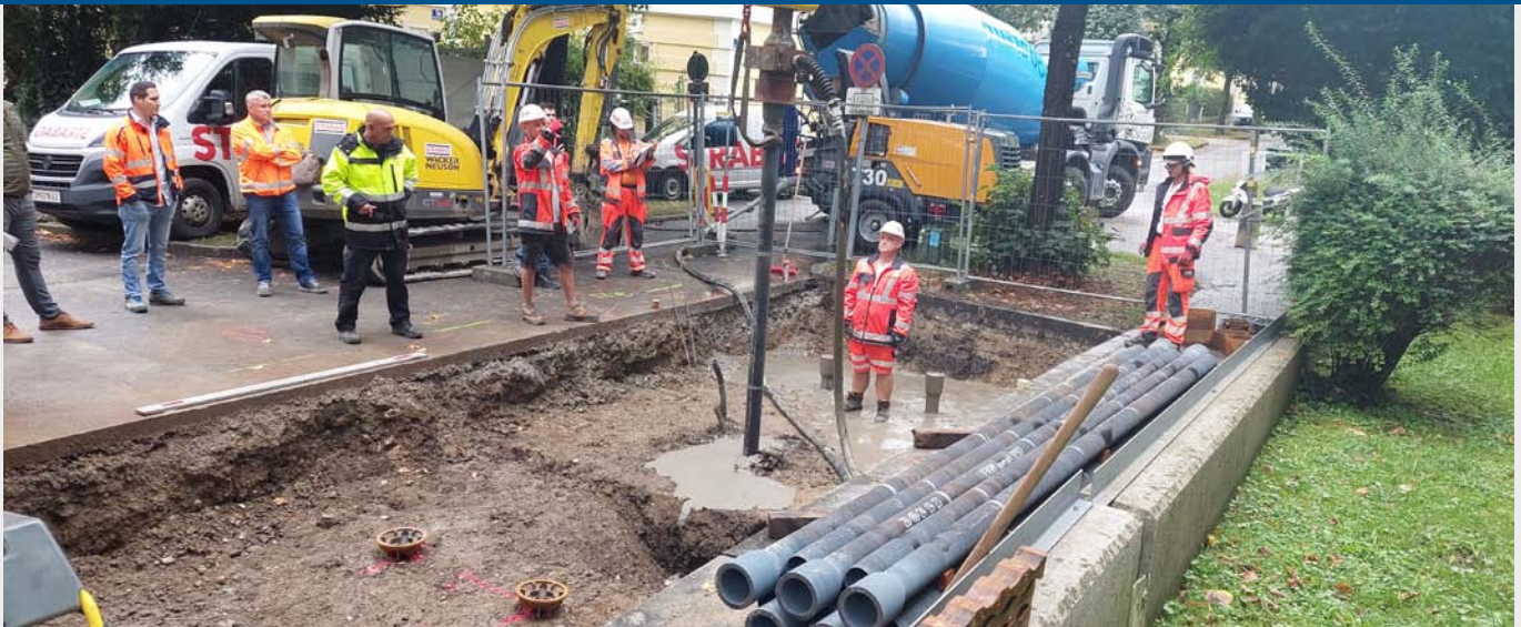
Herstellung Probepfahl zur Überprüfung der Bodenkennwerte
