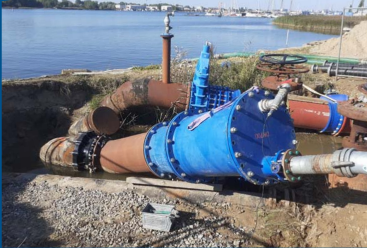
Molchschleuse zur Einführung des „Acquarius“ am Ostufer der Warnow
