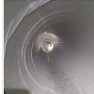
Innenansicht des eingebauten GFK-Schlauchliners DN1500 mit tolerierbaren Falten im Bogenbereich
