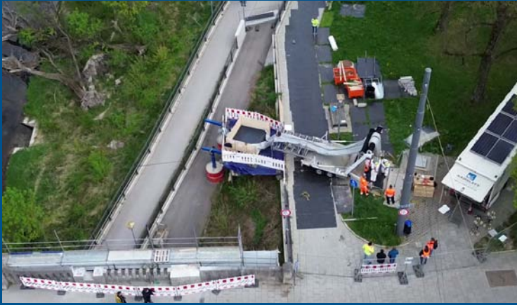
Baustellenansicht aus der Vogelperspektive beim Einzug des Liners DN1500
